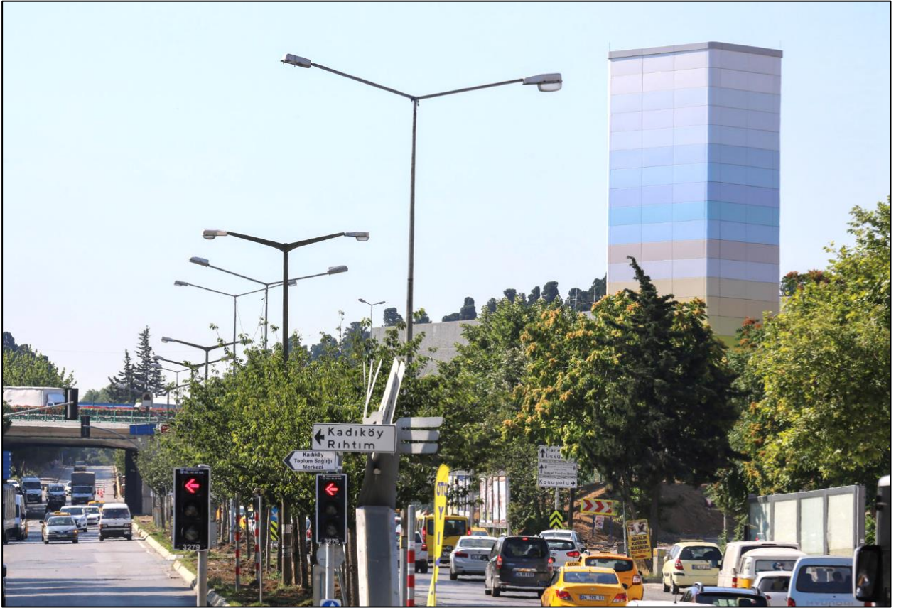
Resim 11: Asya Yakası Havalandırma Bacası
