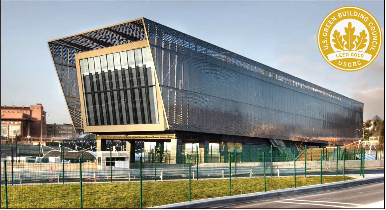
Resim 16: Avrasya Tüneli İşletme ve Bakım Binası
