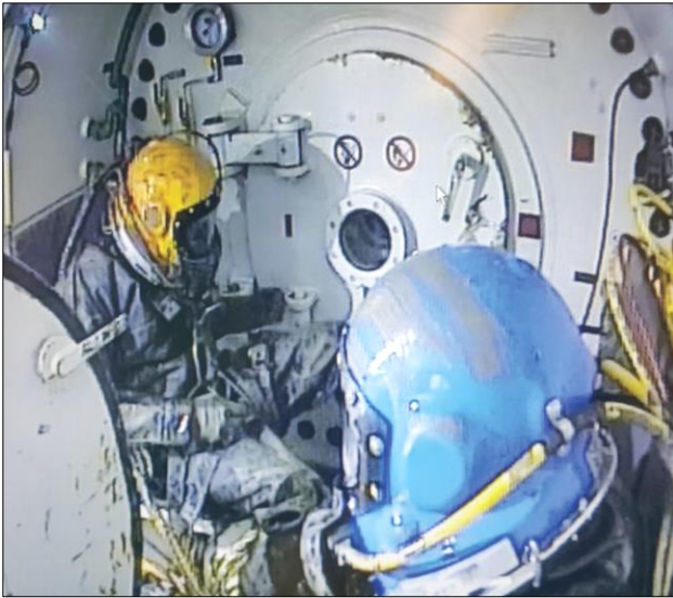
Resim 3: Basınç Hücresindeki Özel Eğitimli Endüstriyel Dalgıçlar (TBM)
