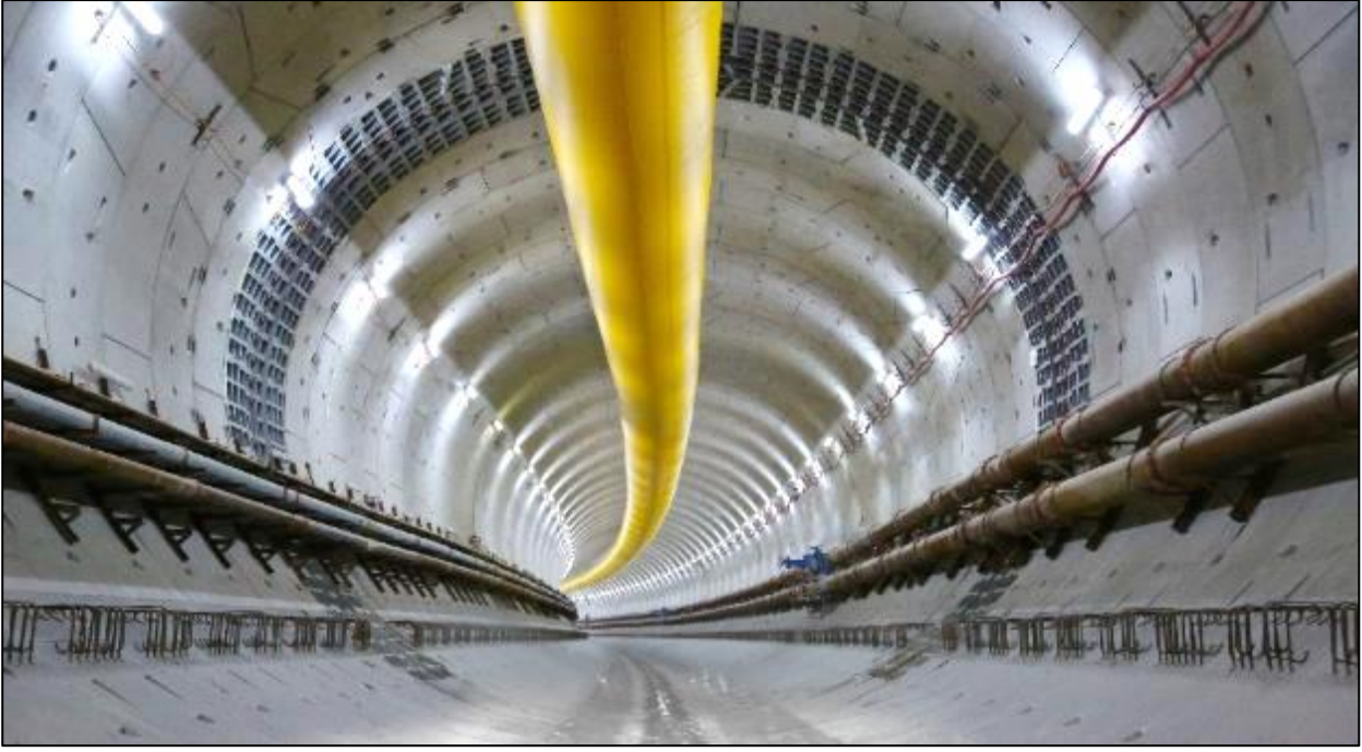
Resim 8: Montaj Sonrası Sismik Bilezik
