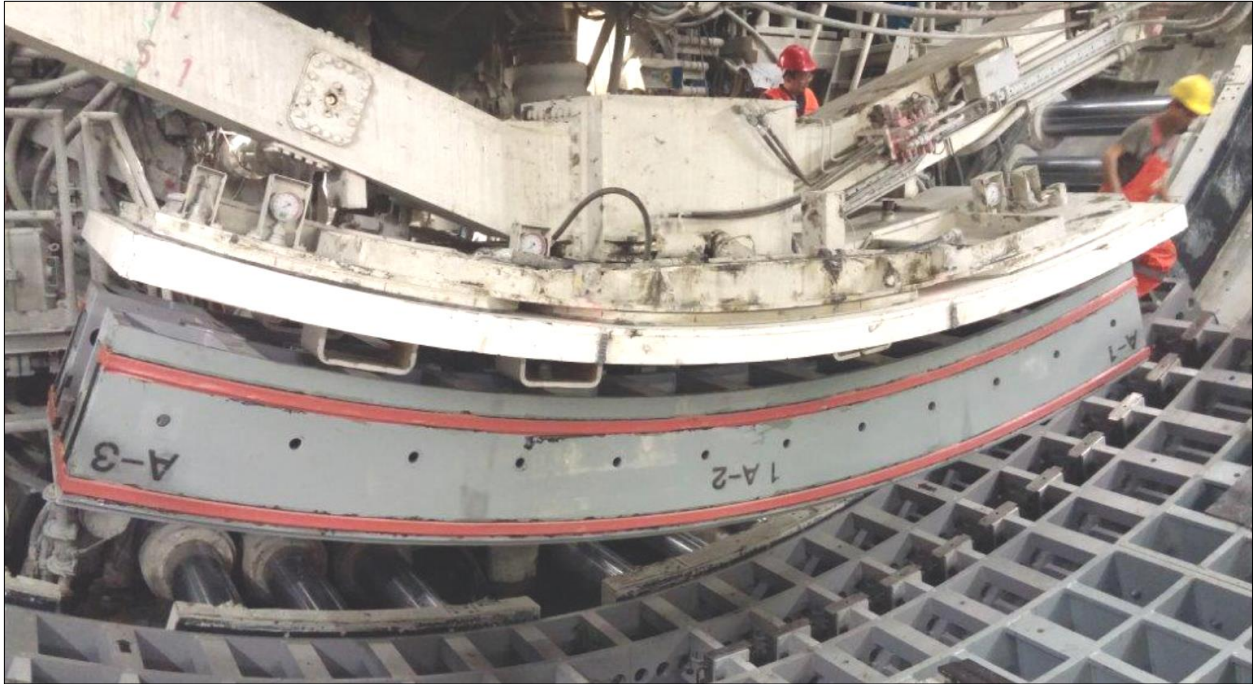
Resim 7: Sismik Bilezik Montajı
