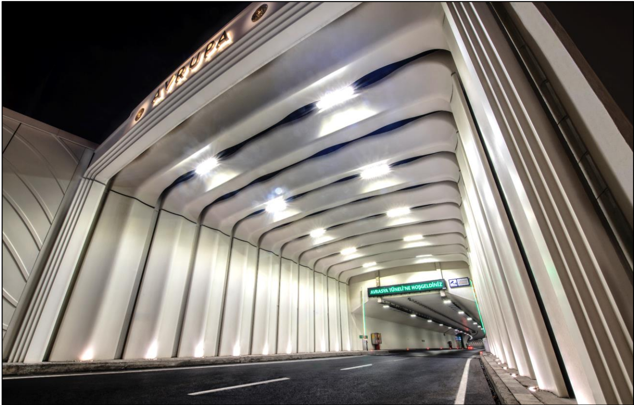
Resim 14: Avrasya Tüneli Portal Girişlerindeki “Gülbezek”, “Çarkıfelek” ve “Martı Kiriş” Mimari Uygulamaları
